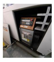
La planta de emergencia se encuentra localizada en la planta baja, dentro del estacionamiento techado y se autoanaliza todos los lunes por las mañanas. Dicho análisis dura aproximadamente 20 minutos llevando a cabo un ciclo en el cual se prende automáticamente y registra su temperatura, su voltaje de encendido, se autoanaliza todo el motor, así como el generador de energía.
