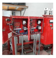
También durante su recorrido semanal el Jefe de Mantenimiento debe revisar las dos bombas de agua localizadas en el cuarto de bombas al inicio del estacionamiento de planta alta verificando que estén encendidas, que no presenten fugas ni calentamiento y que tengan una adecuada presión de agua de acuerdo con su manómetro, así como ausencia de ruidos extraños, anotando las observaciones durante cada visita
